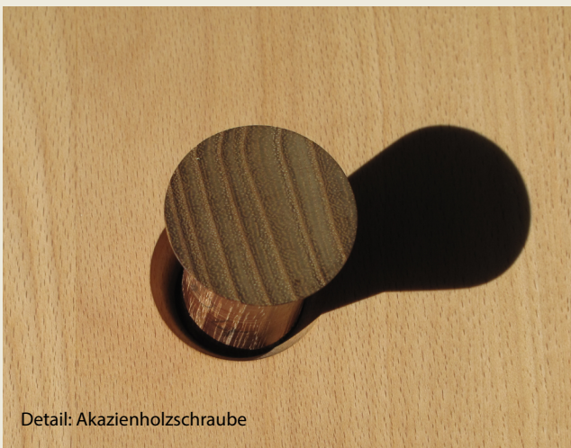
Detail: Akazienholzschraube in der Tischplatte versenkt
